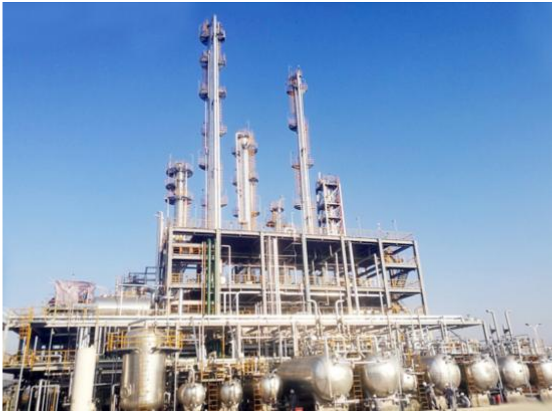
图：公司年产 2 万吨新能源锂电池电解液溶剂项目
